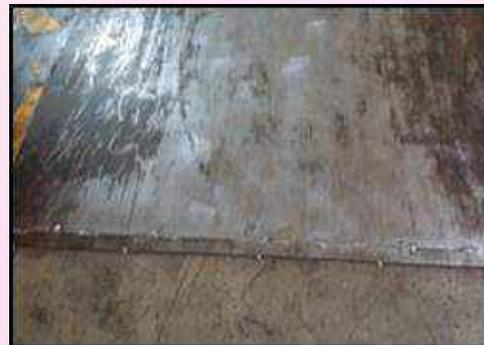
【圖五 現場造成工傷突出鋼板，請機務組磨平，避免再被絆倒】
